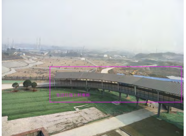
生活垃圾上料廊桥
